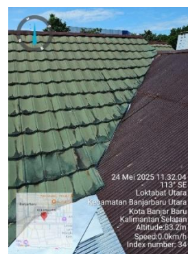
Kondisi Atap setelah dilakukan penambahan jurai dalam dan penggantian material
