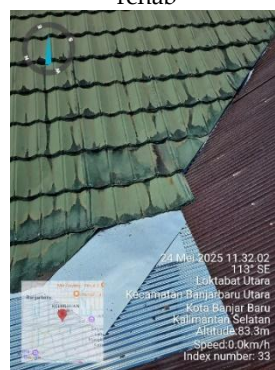
Kondisi Atap setelah dilakukan penambahan jurai dalam dan penggantian material
