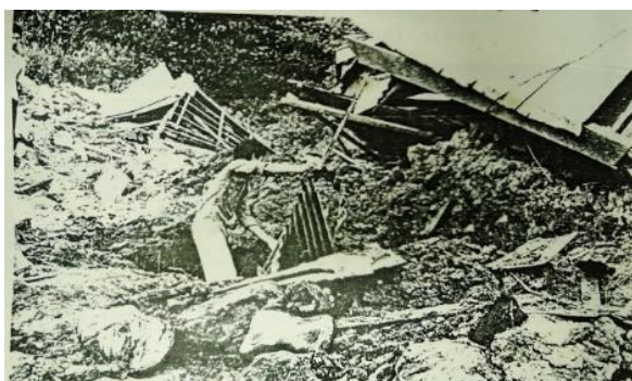
Gambar 1. Runtuhan rumah akibat galodo Repro: Vindo Alhamda Putra, 11 Juli 2021 Sumber: Dokumentasi SATKORLAK
