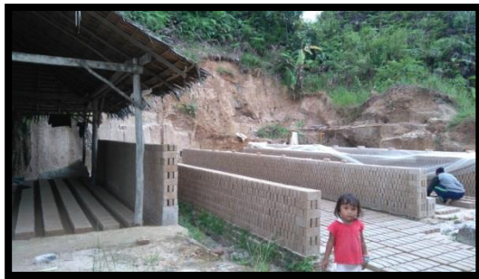
Gambar 1. Lokasi tempat pembuatan bata di Parit Malintang (Sumber: Taufik Akbar, 2018)
