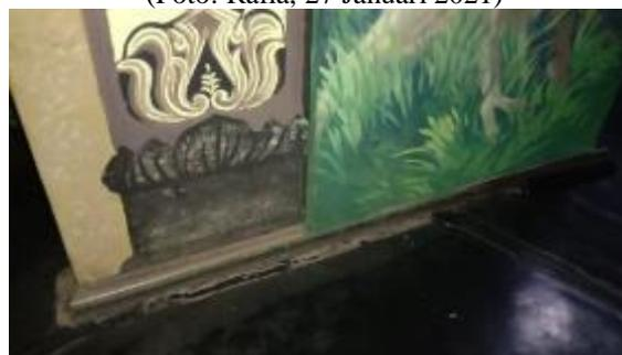
**Gambar 21.** Detail *Side Wing* yang Dapat Digeser pada Panggung *proscenium* di Gedung Wayang Orang Sriwedari
