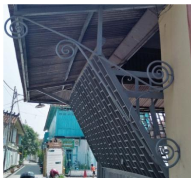
Gambar 15. “Motif Geometris Pilin ” yang terdapat di bagian Konstruksi Atap “Rumah Batu ” (Foto : Mukhsin, 2018)
