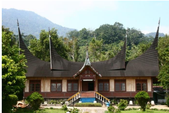
Gambar 3. Rumah Gadang Bodi Chaniago, PDIKM, Padangpanjang [sumber: http://www.panoramio.com/photo/12360722 ]
